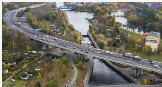
Der Ersatzneubau der Rudolf-Wissell-Brücke und Umbau des Autobahndreiecks Charlottenburg sichern langfristig die Leistungsfähigkeit und Nutzbarkeit eines zentralen Abschnittes der Berliner Stadtautobahn A 100
