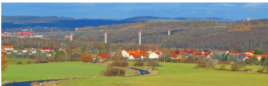
Ansicht der Gottliebatalbrücke mit dem Ortsteil Goes am 12.12.2023
