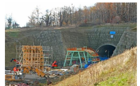
Tunnelportal West Bewehrungsgerüst
