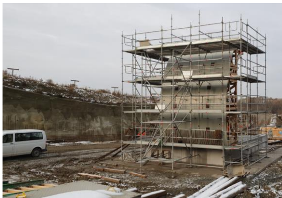
Nachgebildeter Bereich des Probekörpers im Plan und Schalung des Probekörpers auf der Baustelle
