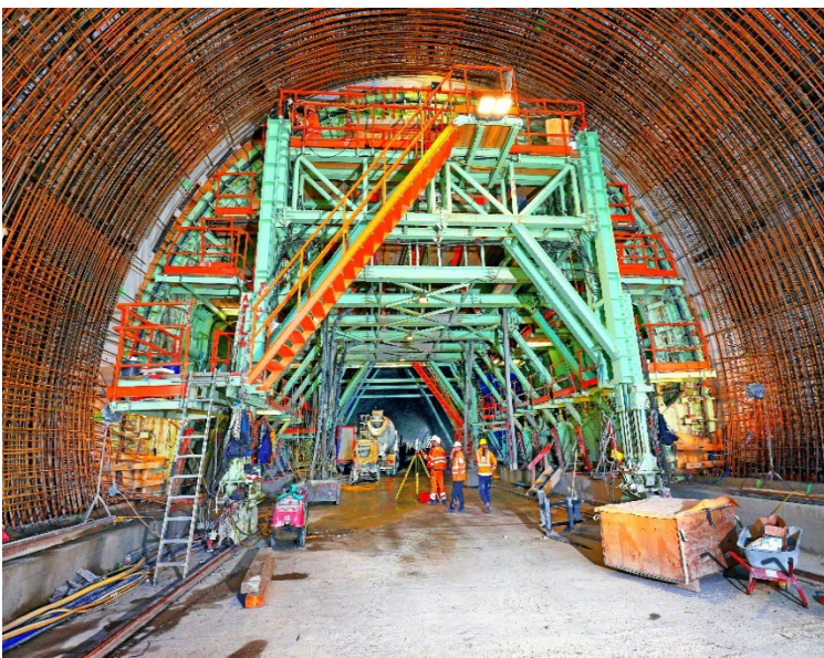
Betonieren eines Gewölbeblocks
