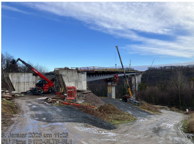
Überbau in Endlage mit Widerlager, Blick vom Kohlberg Foto: EHS
