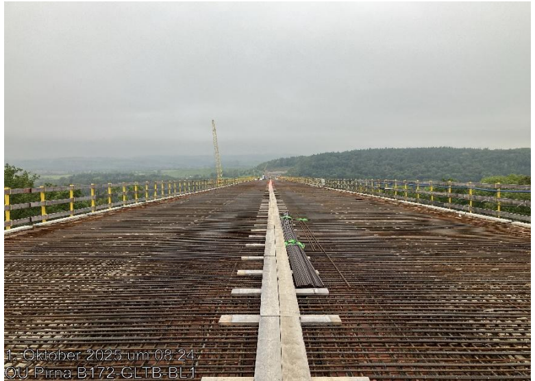
Bewehrung der Fahrbahnplatte auf den Fertigteilen Foto: EHS
