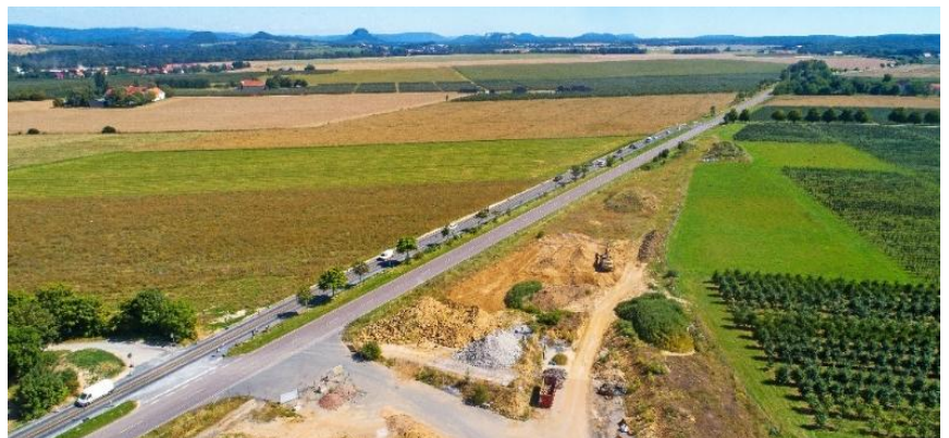
Umleitung der B 172 auf dem Sonnenstein zum Herstellen des Anschlusses neue B 172 an alte B 172 Foto: Legrand
