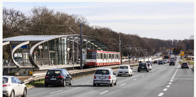
Die Bundesstraße B 1 wird zur Autobahn ausgebaut
