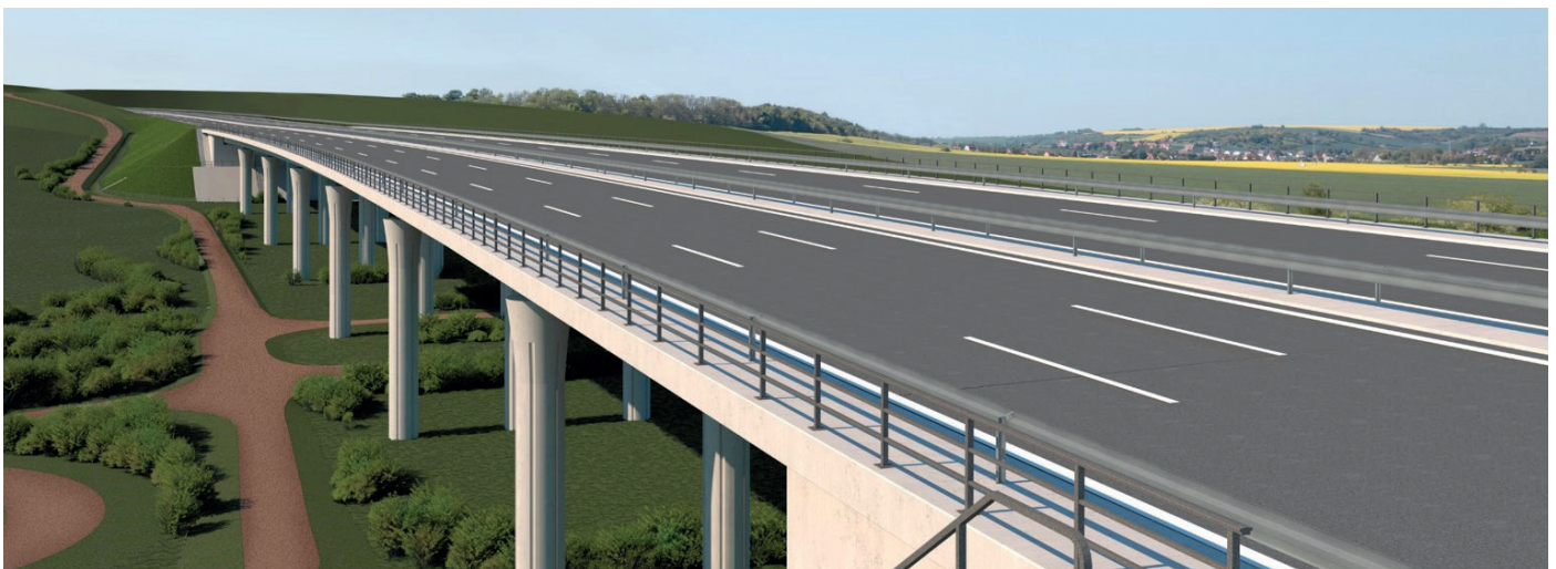
Talbrücke Benkendorfer Bach
