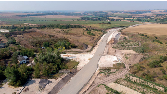
L 159n im Bereich Schießplatz, künftige Anschlussstelle Salzmünde
