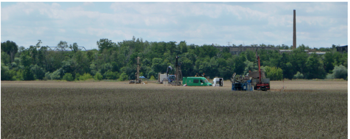
Saaleaue: Bohrungen zur Baugrunderkundung
