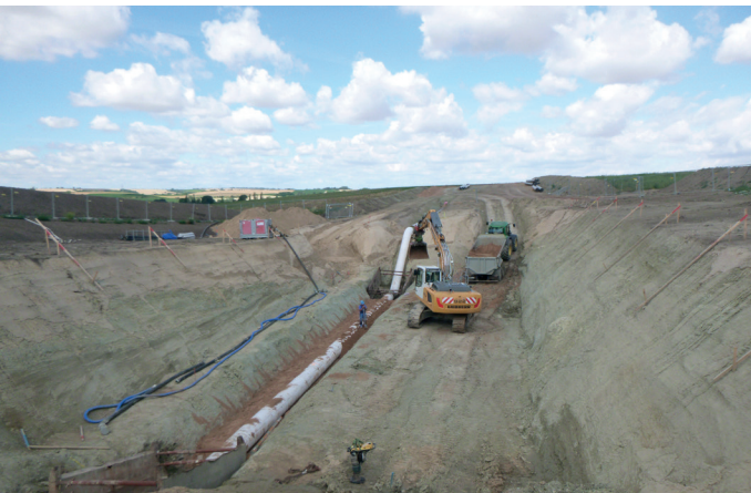
Leitungsumverlegung MVL, Bauabschnitt 1: Bereich Düker – Querung A 143 – DN700
