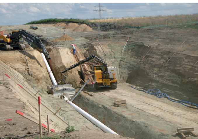
Leitungsumverlegung MVL, Bauabschnitt 1: Bereich Düker – Querung A 143 – Rohrgraben DN700
