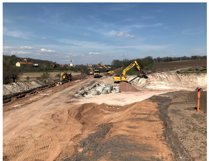
Grundhafter Ausbau der L 173 zwischen Benkendorf und Salzünde
