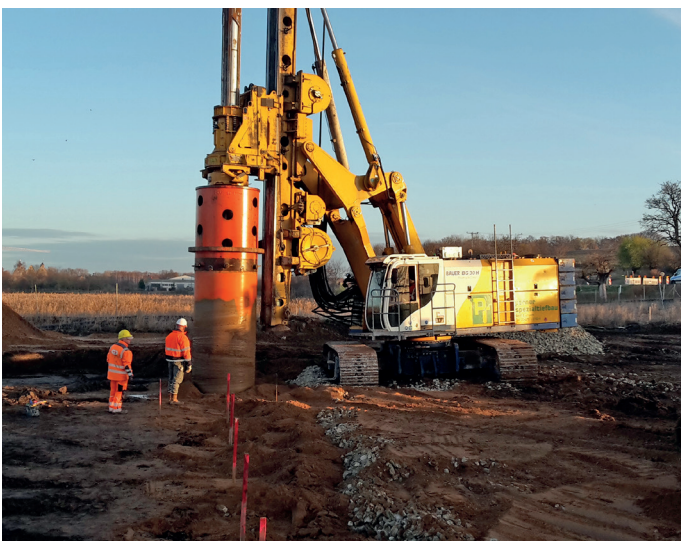
Bodenaustausch im Versickerbecken an der L 173 und L 159 neu
