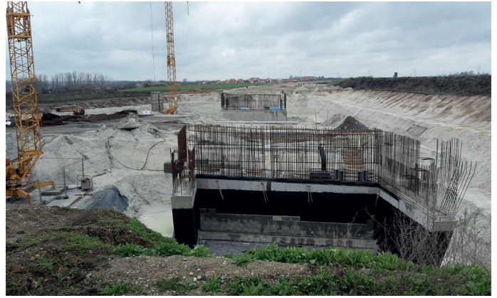
Das erste Widerlager der Brücke an der AS Salzmünde ist fertiggestellt
