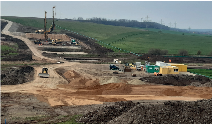
Talbrücke Benkendorfer Bach: Herstellung der Gründung mit zwei Bohrgeräten, Blick vom nördlichen Widerlager nach Süden
