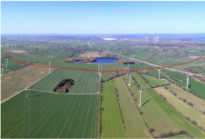
Der 7. Bauabschnitt verläuft von der B 431 in der Nähe der Gemeinde Engelbrechtsche Wildnis bis zur A 23 bei Hohenfelde.
