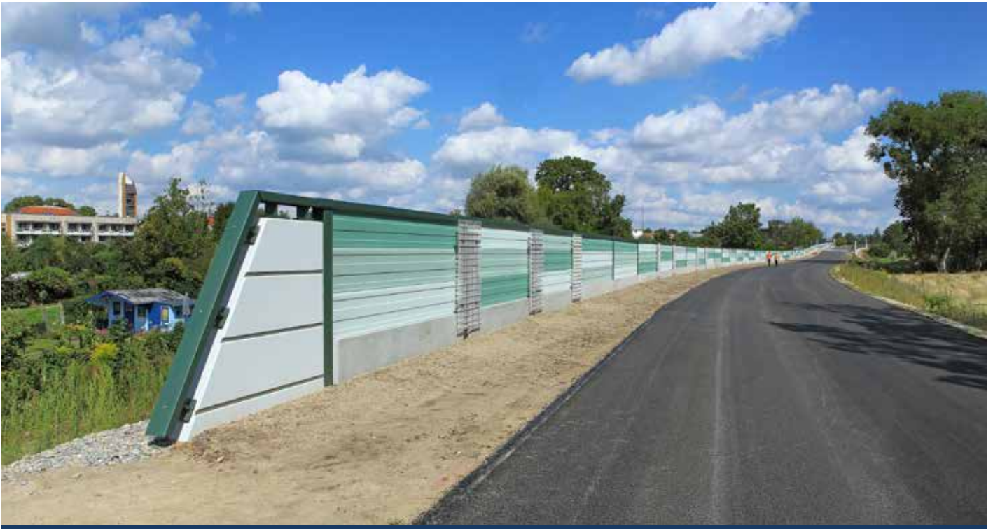
Kurz vor der Fertigstellung: Lärmschutzwand im Zuge der neuen Trasse
