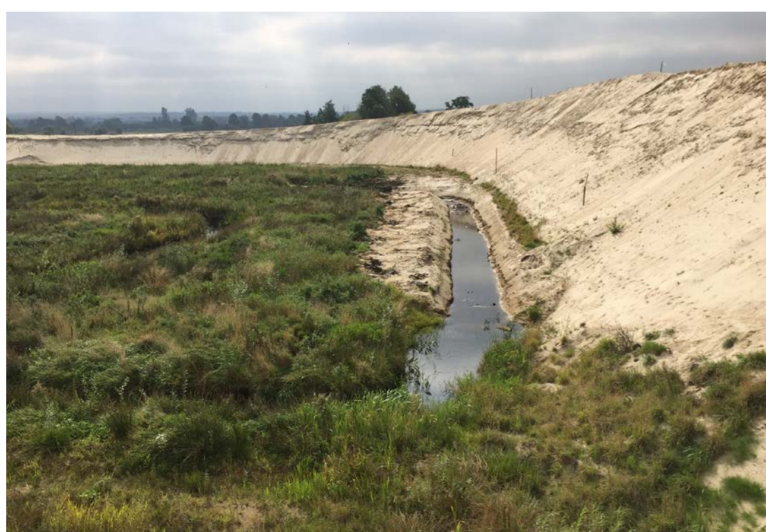
Überschüttung und Entwässerungsgraben
