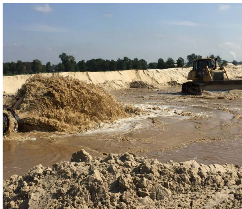
Einspülen des Sand-Wasser-Gemisches
