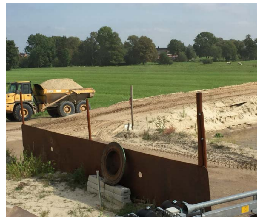
Abbau/Vorbelastung des Sandes
