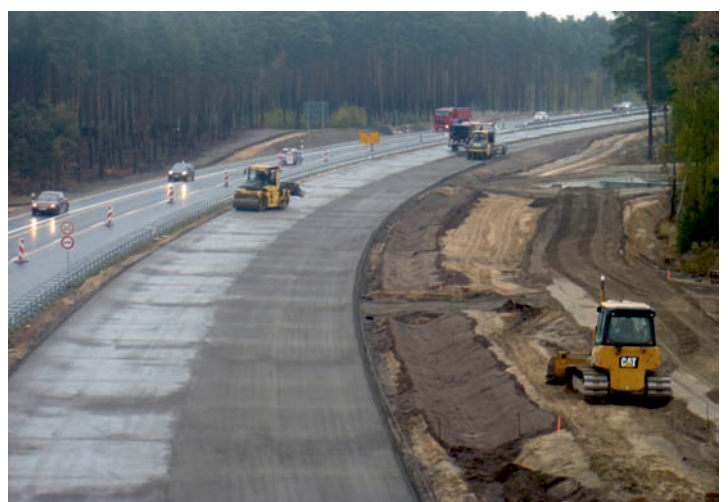
Einbau hydraulisch gebundener Tragschichten, Bauende
