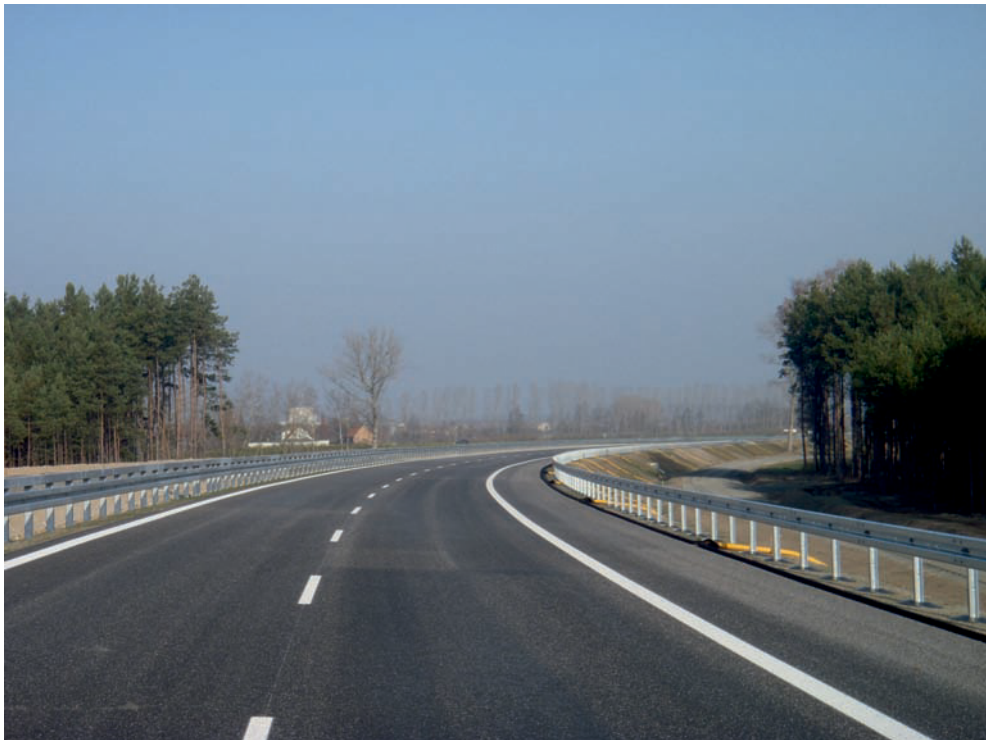
Fertiggestellter Streckenabschnitt Richtungsfahrbahn Trebbin
