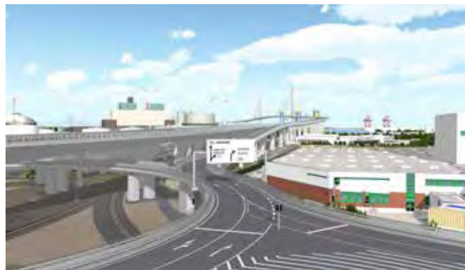
Der Verteilerkreis bekommt zwei Fahrstreifen. Die Einfahrten in den Verteilerkreis sind mit Ampeln signalisiert
