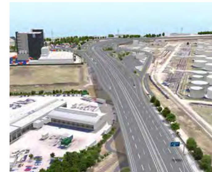
Die A 26 verläuft als Hochstraße über die Insel Hohe Schaar. Blick in Richtung Westen
