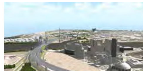
Auf der westlichen Vorlandbrücke steigt die Hafenpassage zur Süderelbe hin an. Blick in Richtung Osten
