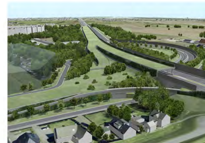
Ansicht des Autobahndreiecks an der A 1 mit Galerie
