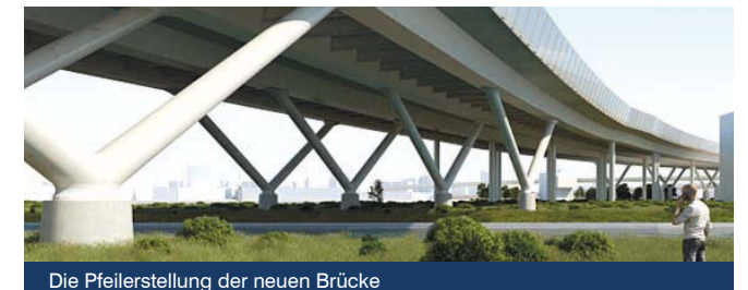
Die Pfeilerstellung der neuen Brücke
