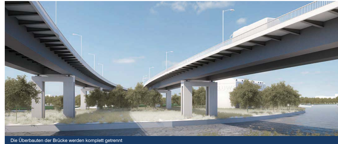
Die Überbauten der Brücke werden komplett getrennt
