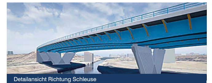
Detailsicht Richtung Schleuse
