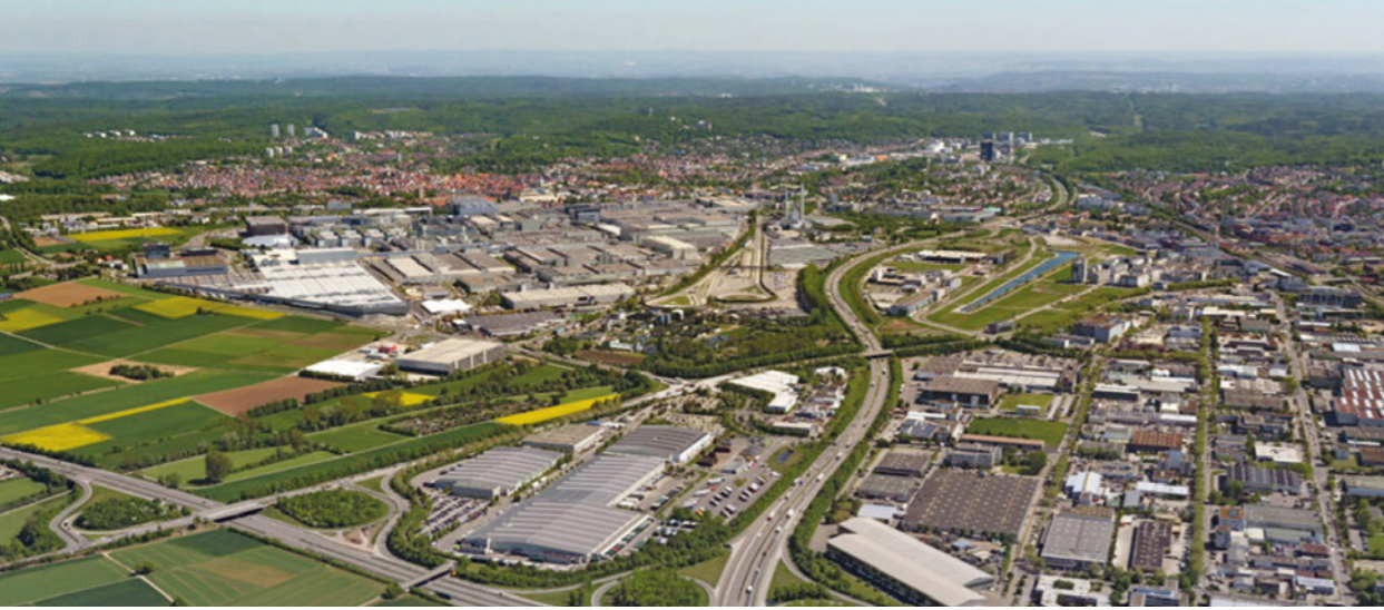
Die A 81 wird auf sechs Fahrstreifen erweitert.
