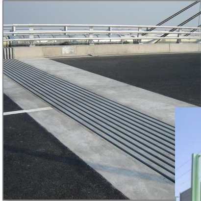
Schallgeminderte Übergänge zwischen Autobahn und Brücke
