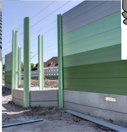
Absorbierende Lärmschutz- wände entlang der Autobahn
