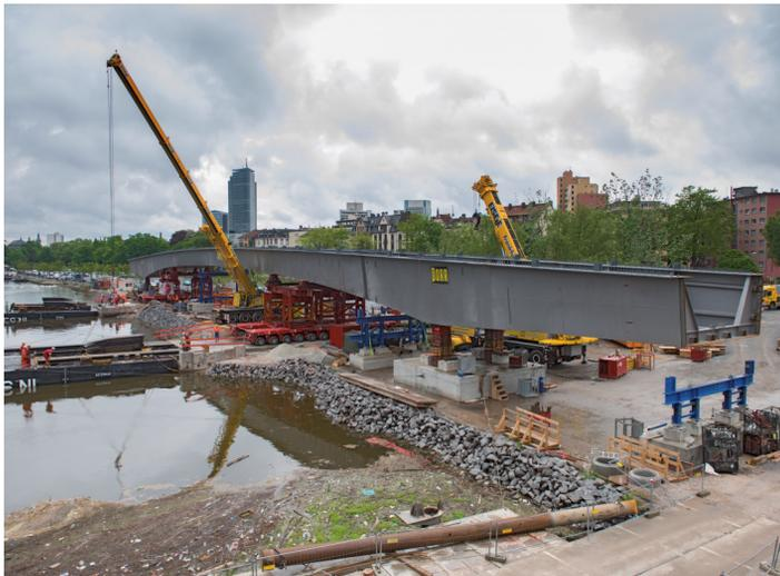
Montage des 150 m langen Stahlmittelteils
