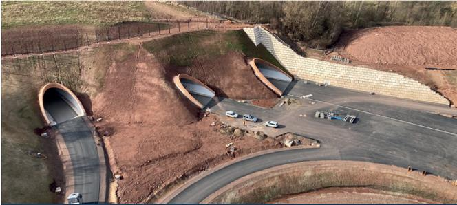
Der **Tunnel Trimberg** bei Oetmannshausen besteht aus zwei parallel verlaufenden Tunnelröhren. Am 20. März 2019 wurde der Durchschlag der Nordröhre gefeiert – 295 Tage nach dem Tunnelanstoß im April 2018. Insgesamt wurden 125.000 Kubikmeter Gestein entfernt, um den 590 m langen Tunnel zu bauen. Inzwischen ist der Tunnel Trimberg baulich fertiggestellt, die Tunnelausstattung erfolgt derzeit.
