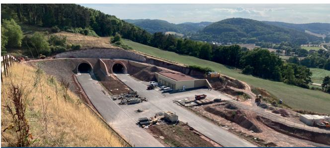
Der 599 m lange **Tunnel Spitzenberg** wurde ab Mitte 2017 gebaut. Er unterquert in Hanglage das Fauna-Flora-Habitat-Gebiet „Werra- und Wehretal“. Auch dieser Tunnel besteht aus zwei parallelen Tunnelröhren. Pro Röhre erfolgten 480 m Sprengvortrieb und 80 m Baggervortrieb. Diese Arbeiten waren aufgrund der schwierigen geologischen Verhältnisse höchst anspruchsvoll.
