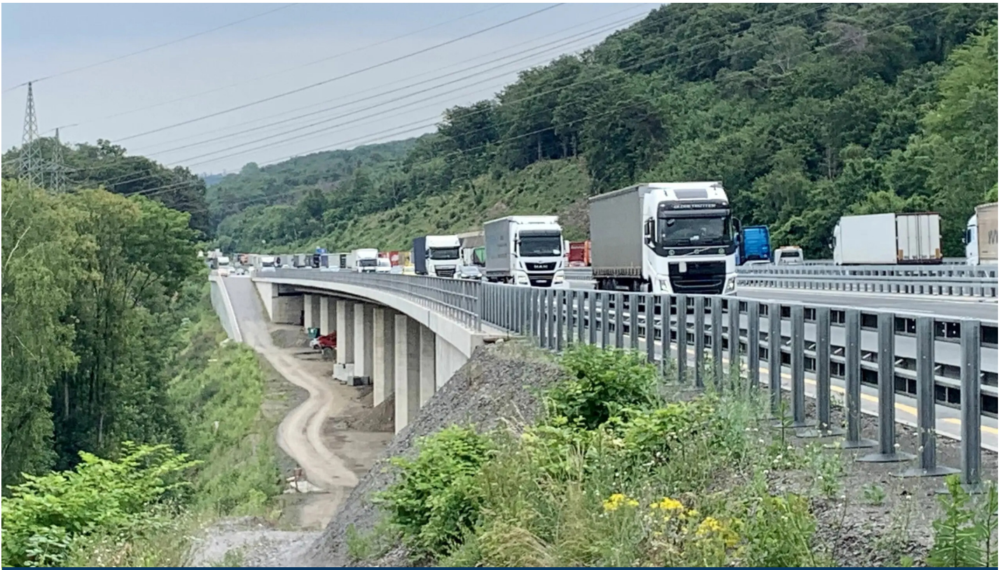
A 1: Die DEGES hat den Ersatzneubau der Talbrücke Volmarstein fertiggestellt
