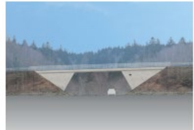
BW 07: Brücke über Waldweg
