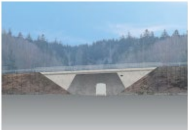
BW 06: Brücke über die Straße am Mühlberg
